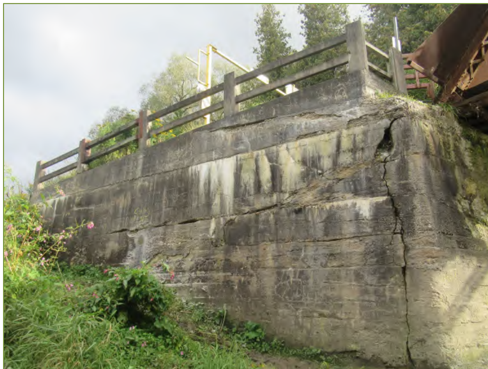
Photo P3 NE Wingwall
